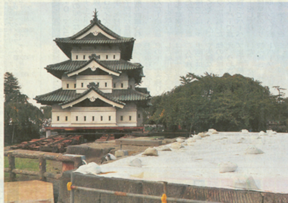
曳屋ウィーク2日目終了後の弘前城天守。油圧ジャッキで動かした分も含め、天守台(右手前)からの移動距離は約35%となった
